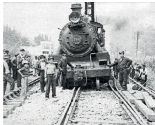
Tren desrielado en la estación de Lontué (San Carlos) tras el terremoto de 1939. Disponible en Memoria Chilena, Biblioteca Nacional de Chile.
