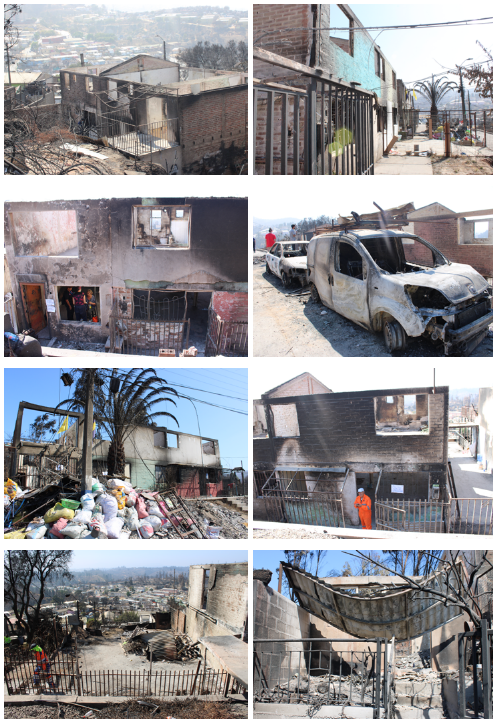
Figura 30. Daños provocados por los incendios en sector El Olivar, Viña del Mar
