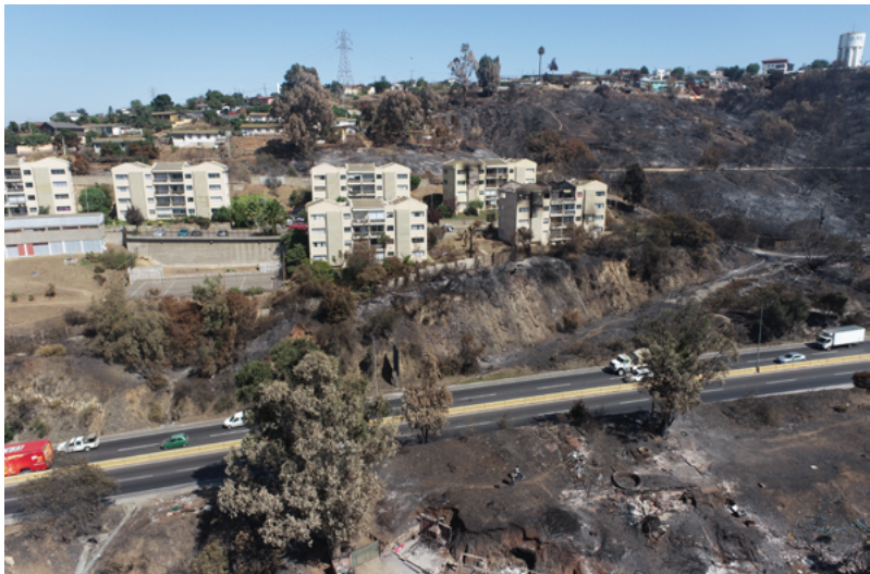
Figura 28. Imagen dron Sector Calle Lennox - Camino Internacional, El Olivar - Viña del Mar. Fuente: imagen dron CIGIDEN.
