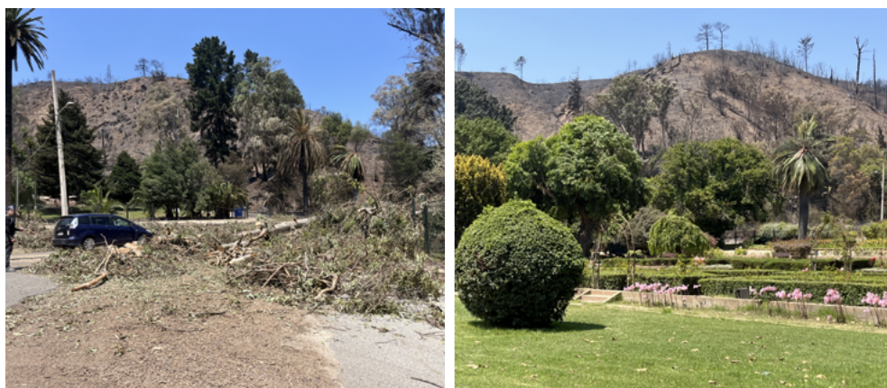
Figura 24. Daños en sector Jardín Botánico (izquierda: sector acceso y derecha: invernadero)
