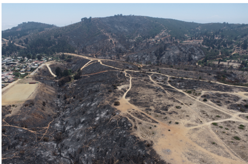
Figura 26: Imagen dron Sector calle Diecinueve, Villa Alegre - Viña del Mar.
